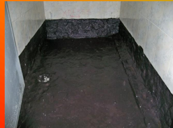
Pemasangan lapisan kalis air
