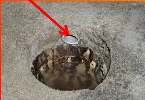
paip aliran dalam mortar lantai
