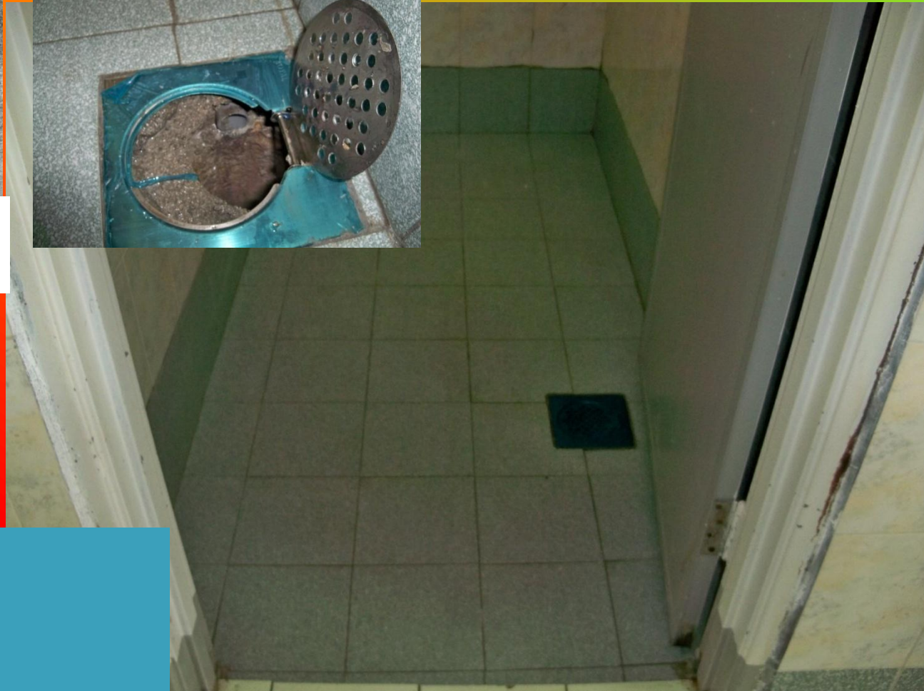
paip aliran dalam mortar lantai
